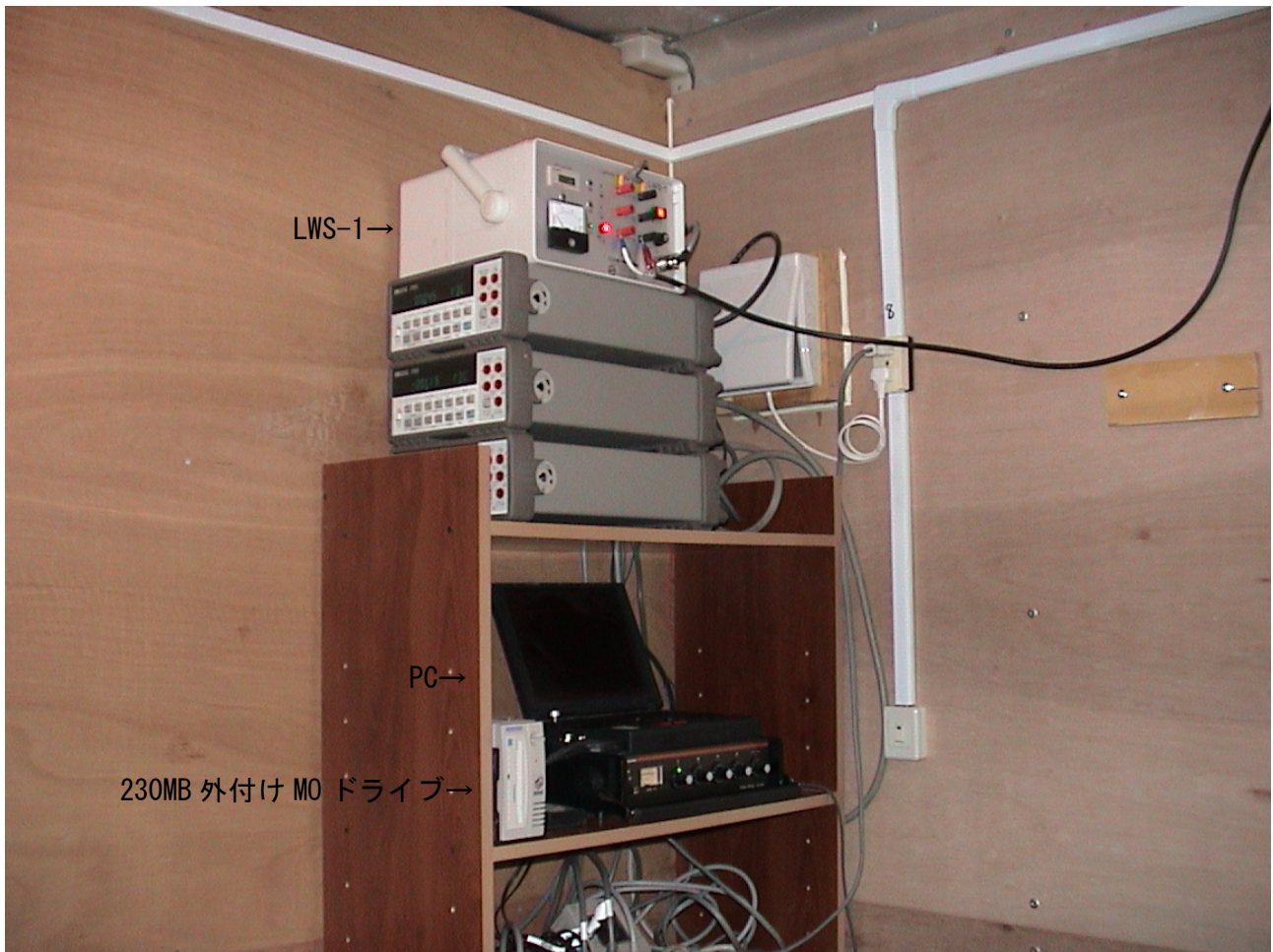
図 1 : ASTE 観測制御室東入口における雷音響測定器端末の設置状況。
