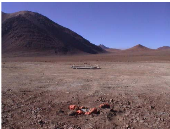
工事写真-15 基礎製作完了（基礎周辺）
