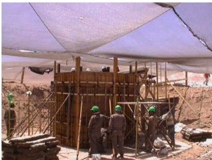
工事写真-10 柱脚部型枠
