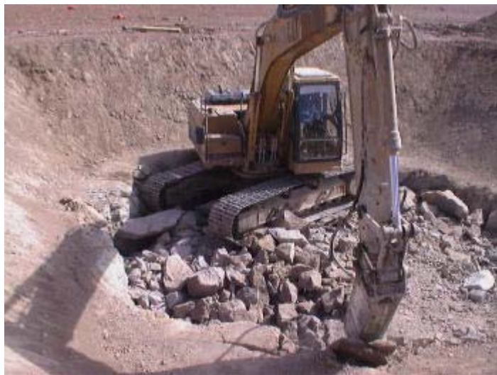
工事写真-3 溶着凝灰岩掘削
