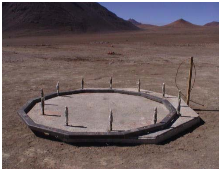
工事写真-14 柱脚部埋戻し完了
