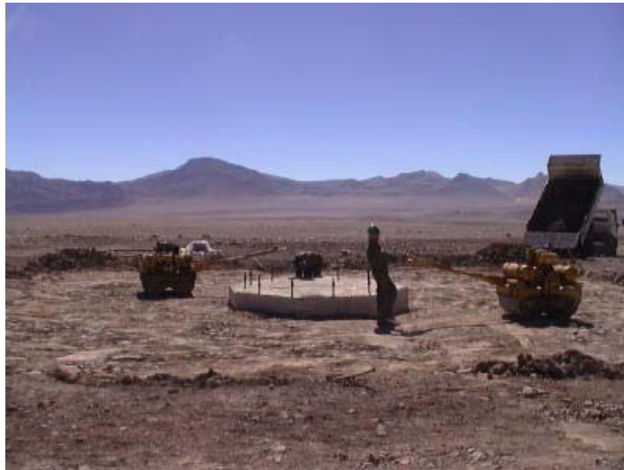
工事写真-13 柱脚部埋戻し作業
