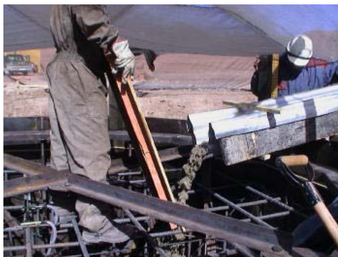
工事写真-11 柱脚部コンクリート打設
