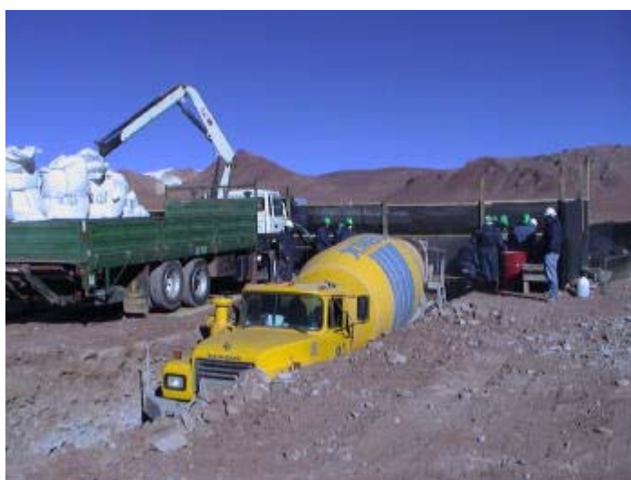
工事写真-6 コンクリート混練
