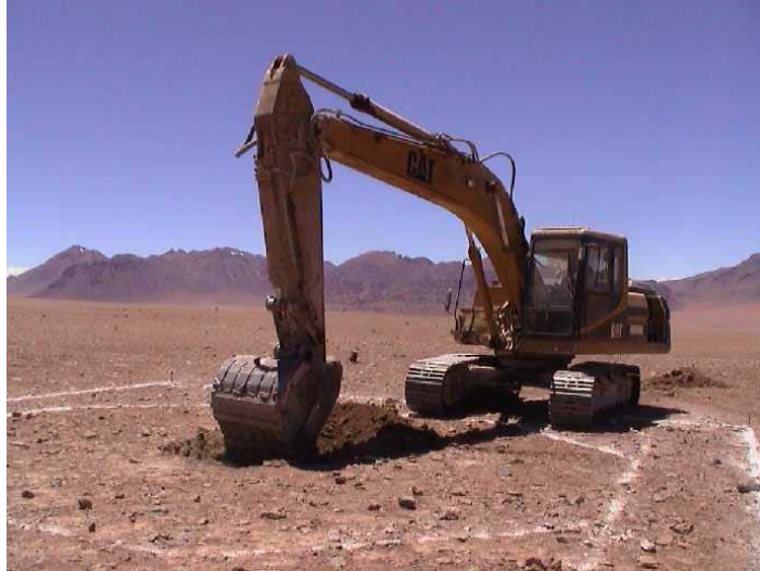
工事写真-1 掘削開始
