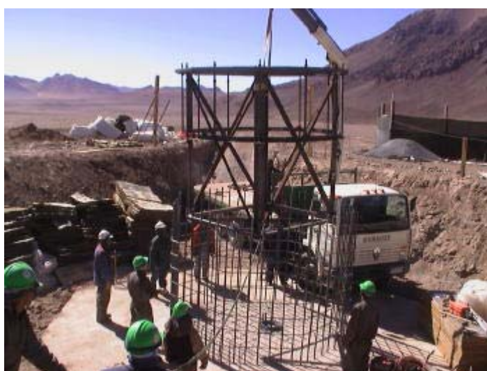
工事写真-9 アンカーフレーム吊り込み
