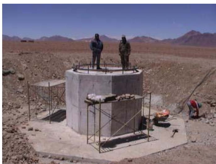
工事写真-12 柱脚部埋戻し前
