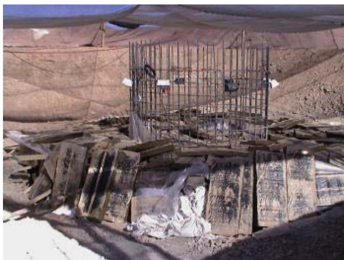
工事写真-8 フーチングコンクリート養生
