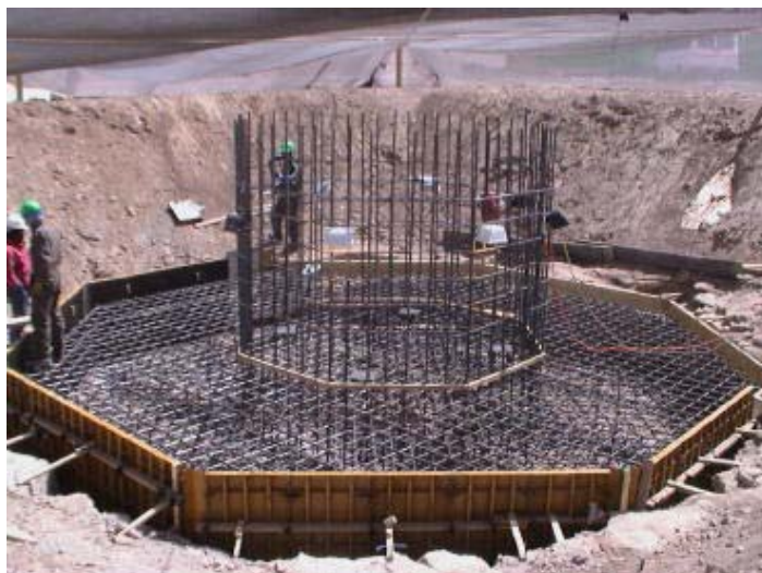
工事写真-4 フーチング部配筋型枠
