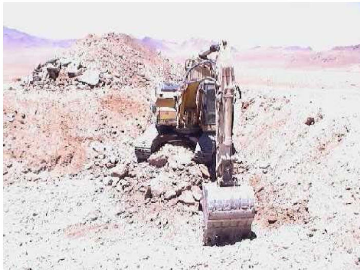
工事写真-2 風化岩掘削
