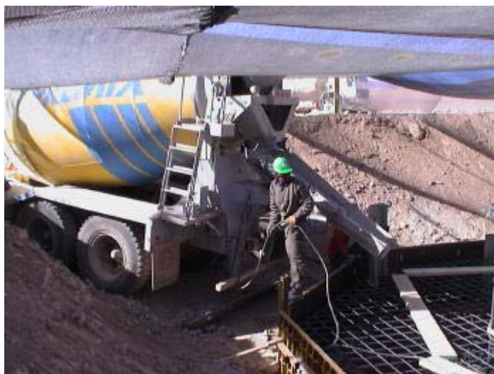
工事写真-5 フーチング部コンクリート打設
